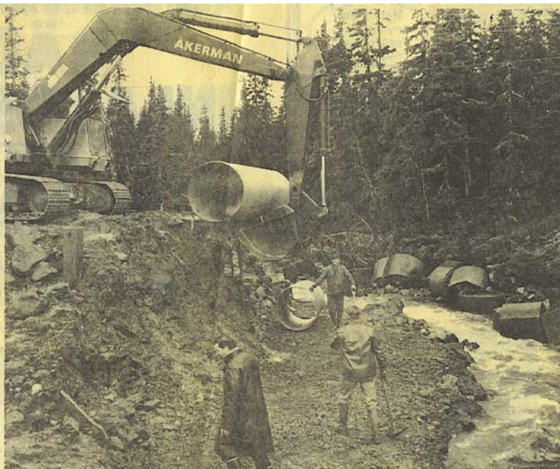
Jöns Olsson och Manne Karlsson kunde vid 17-tiden ta emot den första trumsektionen som Birger Lundin hivade ned med sin grävmaskin.
